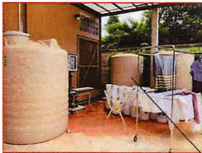
ถังเก็บน้ำใต้ดิน ขนาด 2.50 ลบ.ม. จำนวน 3 ถัง (ใช้สำหรับอาคาร)
